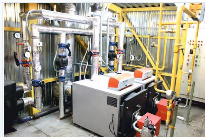
Выполнение строительно-монтажных работ по устройству газопровода и техническому перевооружению котельной мощностью 1,5 МВт
