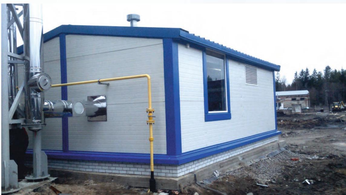
Выполнение строительно-монтажных работ по прокладке наружного газопровода и устройству крышной котельной, мощностью 500 кВт для нужд ООО «ДЦ Арктур»
