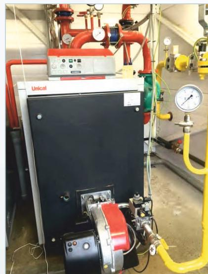
Выполнение работ по монтажу и вводу в эксплуатацию котельной, мощностью 210 кВт для нужд отопления здания завода
